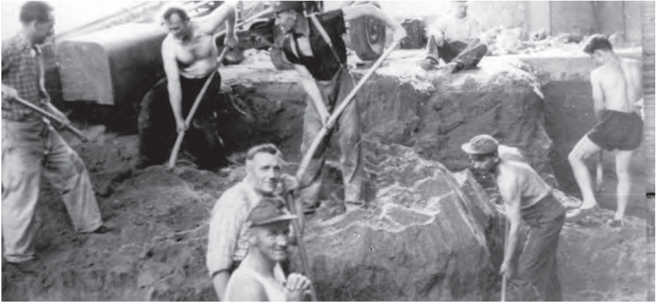
1956 – echte Handarbeit: Der Kelleraushub der TS-Turnhalle
