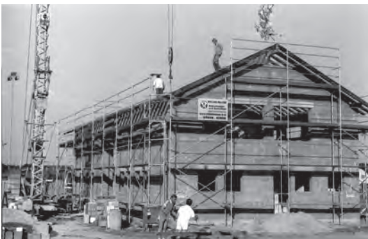
1989: Der Richtkranz steht, der Bau des neuen Sportplatz-Funktionsgebäudes geht in seine Endphase.
